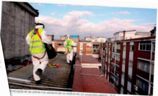
Recuperación de las placas con aislamiento de un edificio en un municipio andaluz. / D. S.
